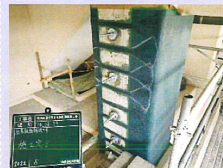
③壁の耐震スリット工事
