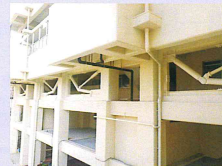
①耐震ブレース工事
