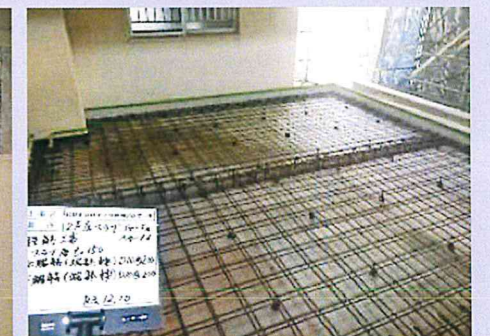
⑤スラブ増設工事
