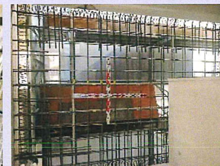
④壁増設工事
